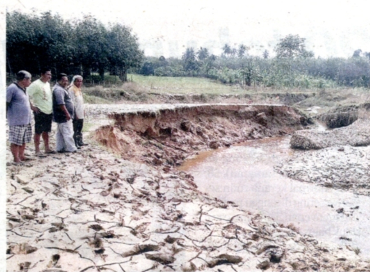
Benteng tandak yang dibina di sungai berdekatan kawasan ladang petani di Paloh Rawa runtuh akibat banjir, baru-baru ini.
