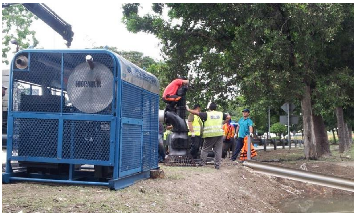
Rajah 2: Portable Pump Dengan Powerpack Unit Di Tapak
