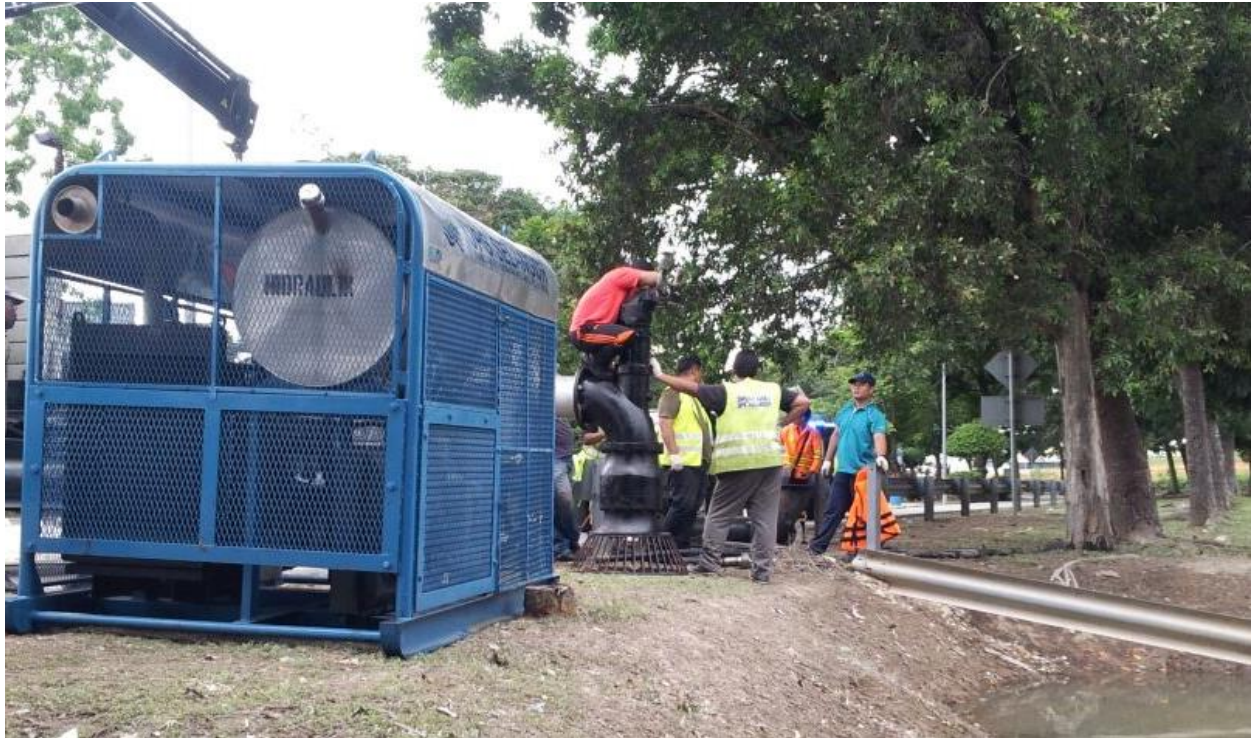
Rajah 7: Portable Pump Dengan Powerpack Unit Di Tapak
