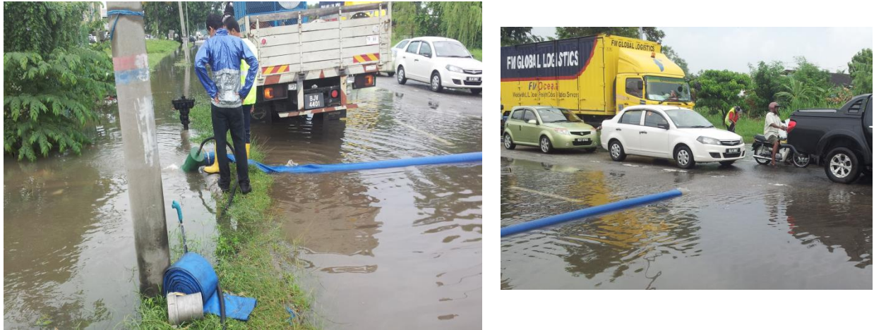
Rajah 6: Pam Digunakan sewaktu Operasi Banjir di Klang September 2013.
