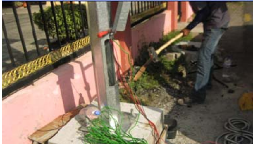
Gambar 3 : Pemasangan pendawaian pada sistem siren
