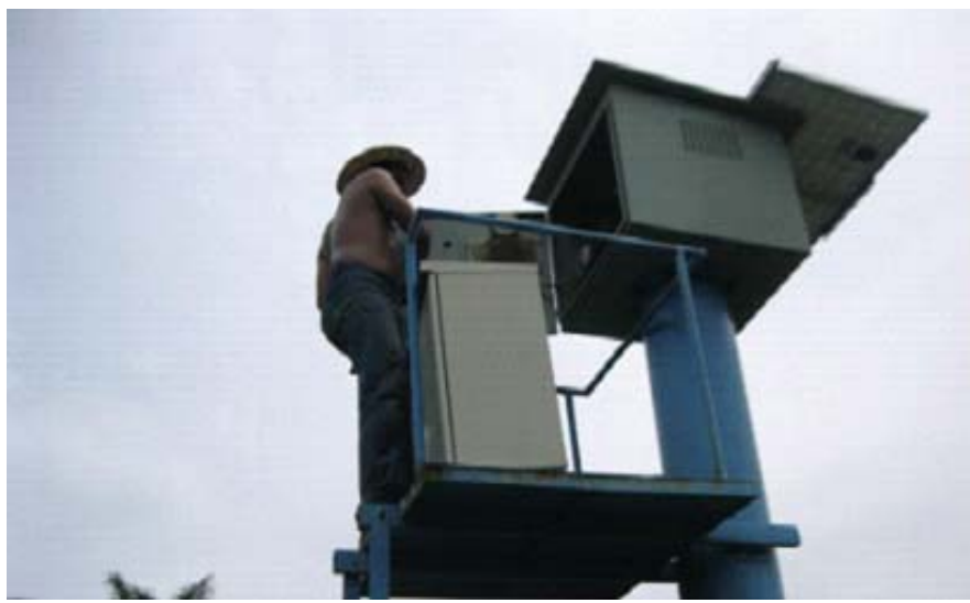
Gambar 2 : Kerja-kerja Menaiktaraf Sistem Siren sedang dijalankan
