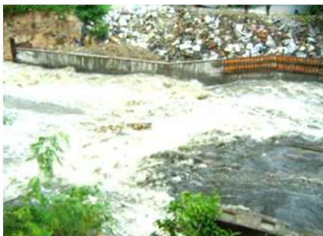
Foto 5: Keadaan air yang deras, bergelora & berpusar menyebabkan hakisan yang serius di tebing
