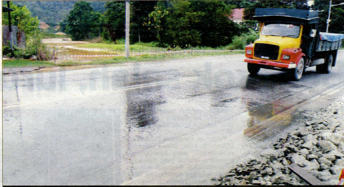
JALAN di Kampung Sungai Raya, Batu 10, Hulu Langat yang sentiasa digenangi air kerana kerja-kerja mengorek tanah yang tidak sempurna.
