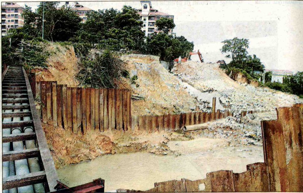
CERUCUK-CERUCUK besi dipasang di tebing Sungai Long, Kajang bagi mengatasi masalah tanah runtuh di situ.
