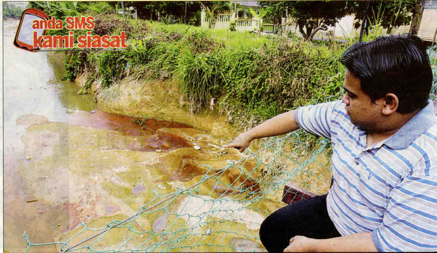
MOHD. ZAID menunjukkan tebing Sungai Sering, Cheras yang semakin melebar akibat hakisan.
