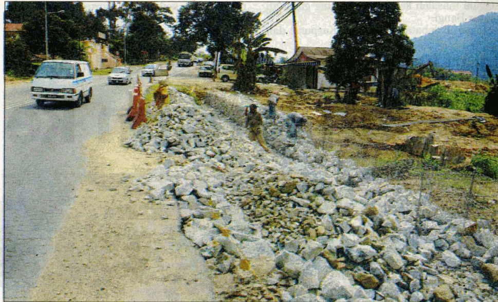
KERJA-KERJA membaik pulih parit Kampung Sungai Raya, Batu 10, Hulu Langat giat dijalankan semalam.
